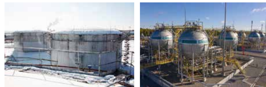
Рисунки 42–43. Емкости для хранения бензина (слева) и газообразного сырья (справа)
