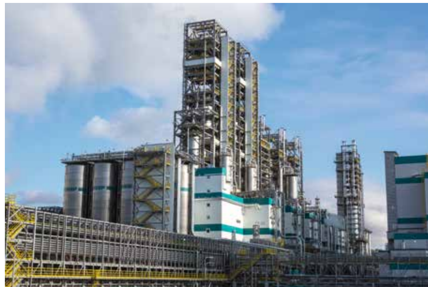
Рисунок 64. Товарные бункеры полиэтилена высокого давления
