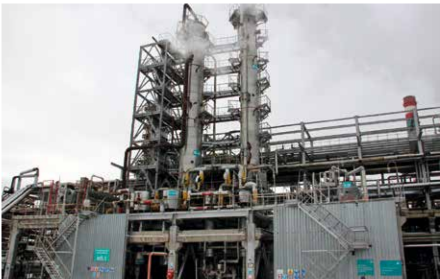
Рисунок 56. Колонна-деэтанализатор
