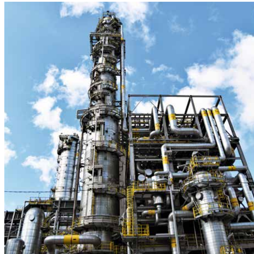
Рисунок 52. Низкотемпературная секция (холодный блок) предназначена для отделения из фракции \text{C}_2 -метана и водорода. Здесь достигается самая низкая температура на производстве -165\text{ }^{\circ}\text{C}
