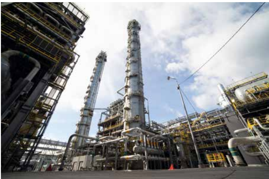
Рисунок 55. Слева – колонна получения товарной БДФ, справа – колонна-депропанизатор
