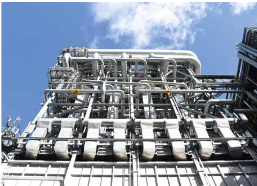
Рисунок 46. Закально-испарительные аппараты (ЗИА)
