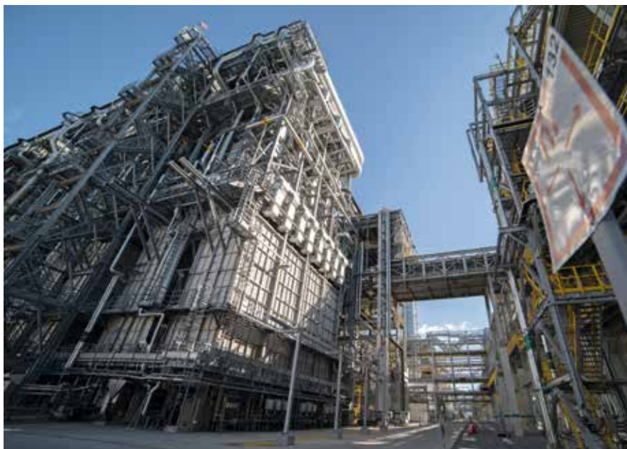
Рисунок 44. Торцевая часть печной секции комплекса пиролиза
