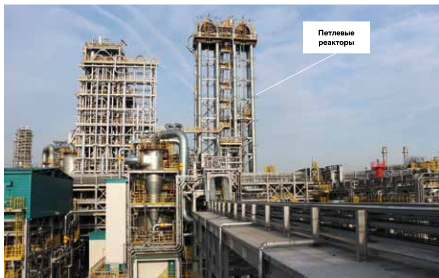
Рисунок 68. Реакторы полимеризации пропилена суспензионного типа
