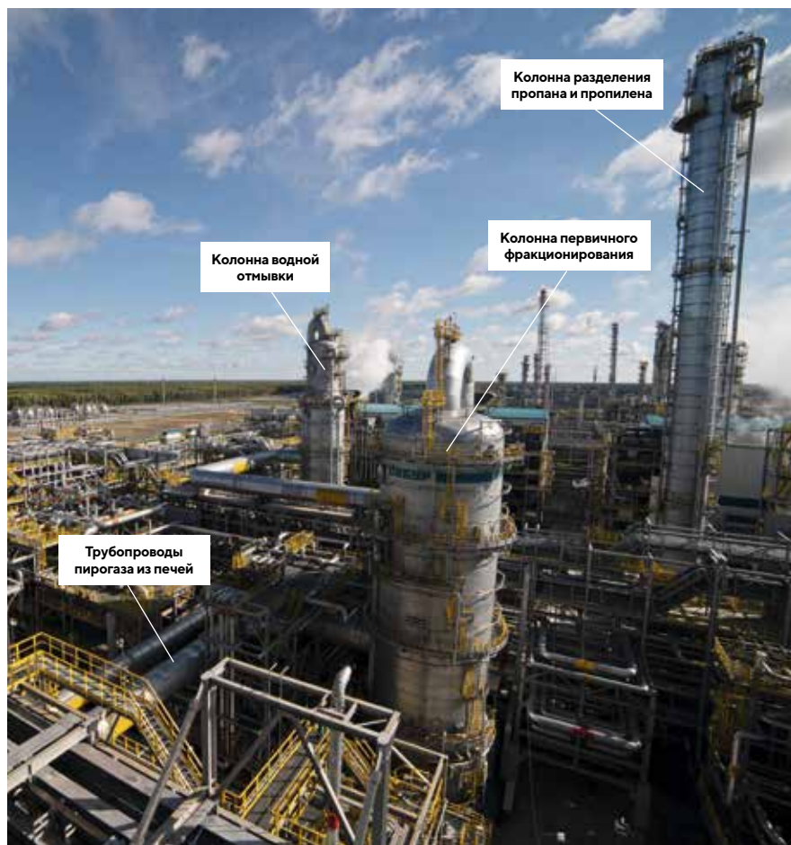
Рисунок 48. Колонна первичного фракционирования — по центру. Колонна водной отмывки — чуть левее. Слева внизу виден трубопровод, подводящий пирогаз от печей в нижнюю часть аппарата. Справа — колонна разделения пропана и пропилена
