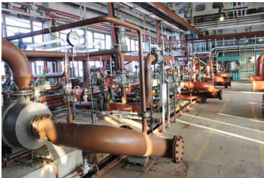
Рисунок 41. Насосы по перекачке сырья со сливной эстакады в парк хранения
