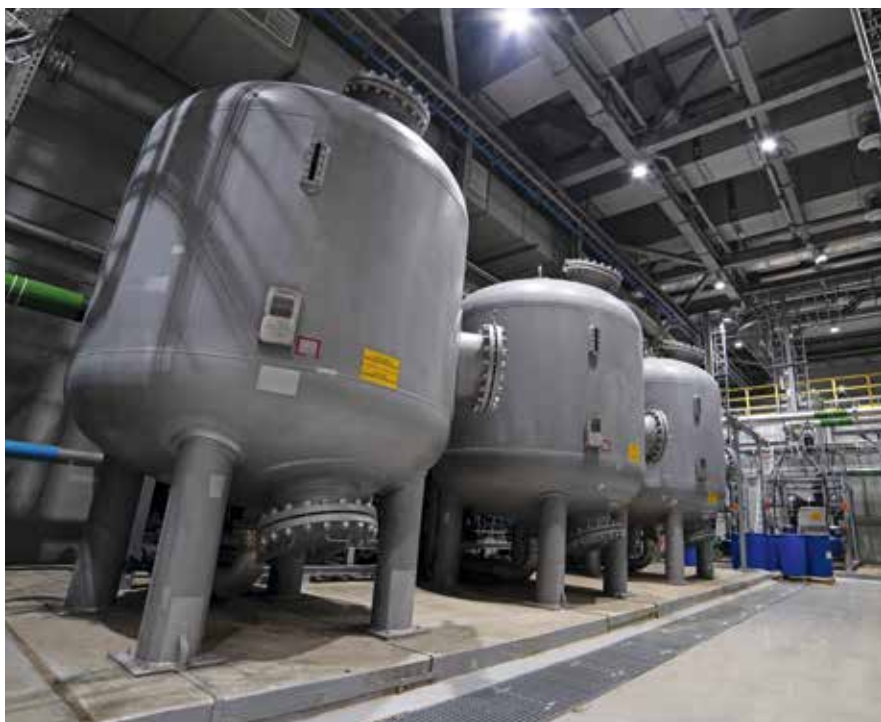
Рисунок 72. Технологическое оборудование установки получения деминерализованной воды
